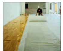
Zwischenlagen aus Schaumfolie schützen ideal Porzellan, Glas und andere empfindliche Teile. Optimal zur Schalldämmung von Laminatböden einsetzbar.
