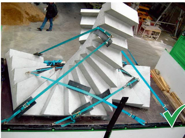
Hier wurde per Direktzurren eine gute Ladungssicherung erzielt. Die Zurrpunkte wurden bereits bei der Produktion der Treppe eingegossen.
